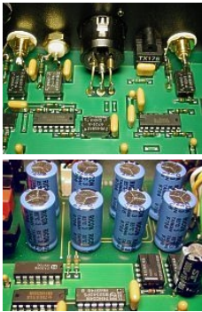
Sezione ingressi digitali con trasformatori professionali, foto sezione stabilizzazione dell'alimentazione
